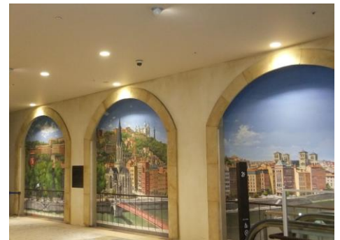
壁面にある騙し絵はLED37wのダウンスポット型 LZD-60767NW
